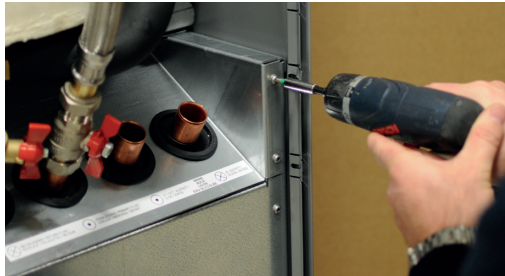
3. Avlägsna kylmodulens fästskruvar.
