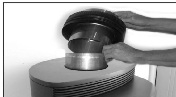
Montera först dit adapterröret enligt bilden ovan. Täta med pannkitt. Placera sedan dit kopplingsstycket, var noggrann med att följa skorstensleverantörens anvisningar.
